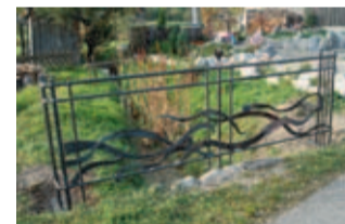
Das fertige Brückengeländer an der Auenstraße
